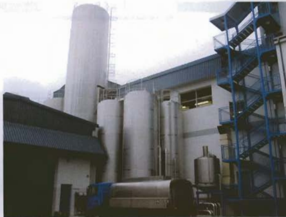
Das Rohmilchlager umfasst nun fünf Tanks à 120 000 l
